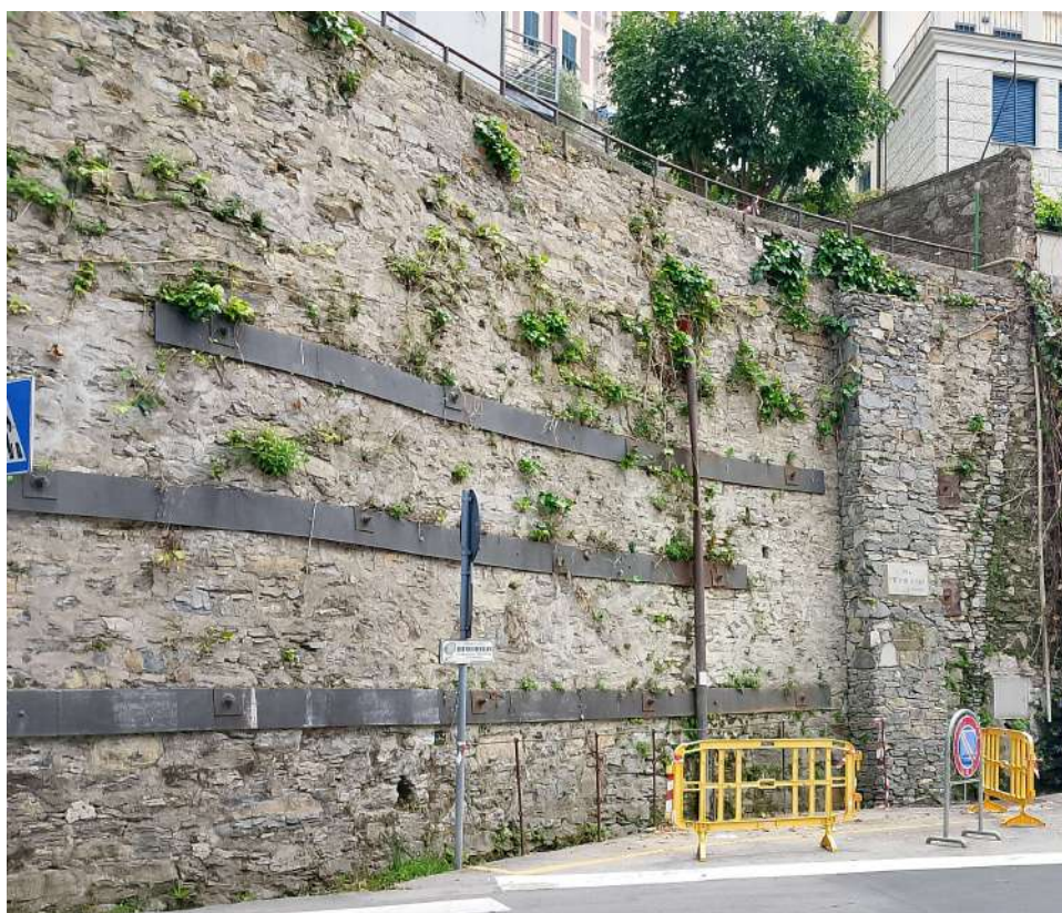
Foto 1: muro oggetto di rifacimento, si notano le pregresse opere di rinforzo strutturale
